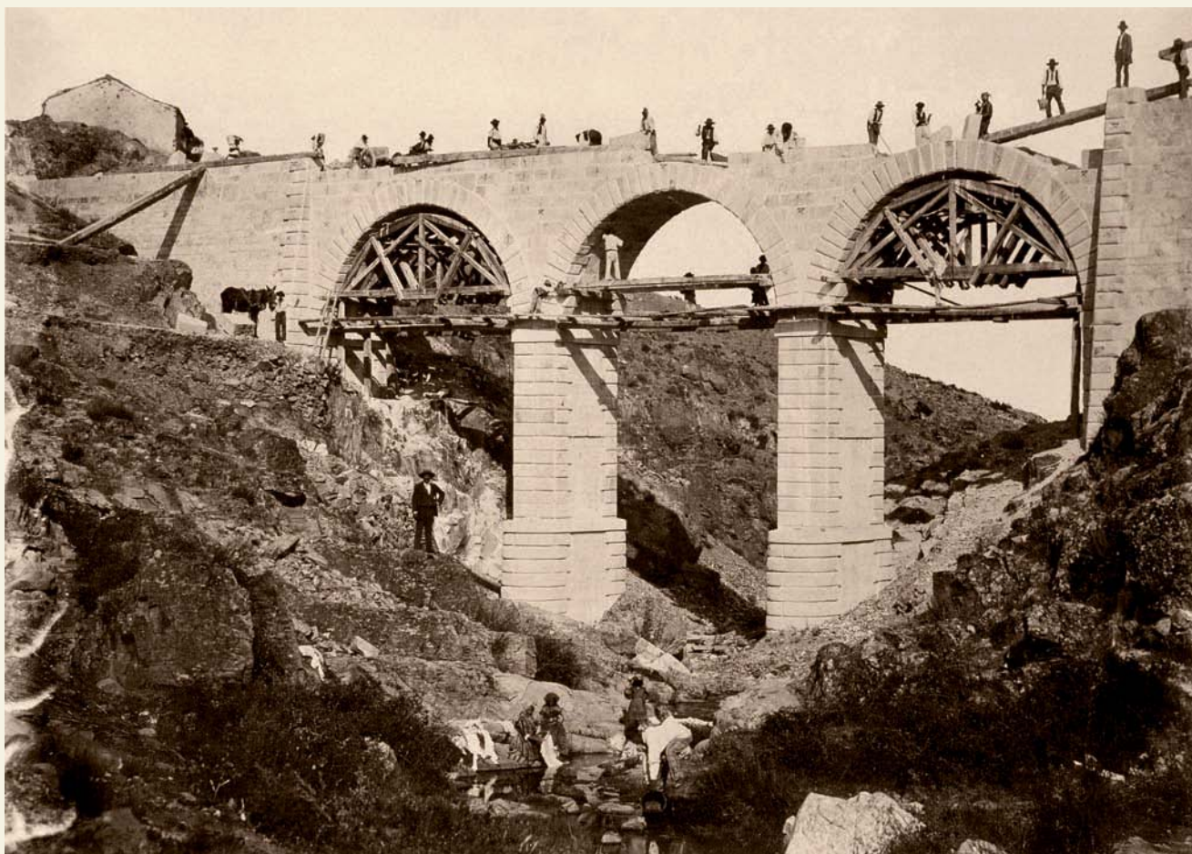
Según las ideas del buen gobierno del XIX, había que invertir en la construcción de las llamadas OBRAS PÚBLICAS . Arriba, trabajos en el acueducto de Mojaipán.
